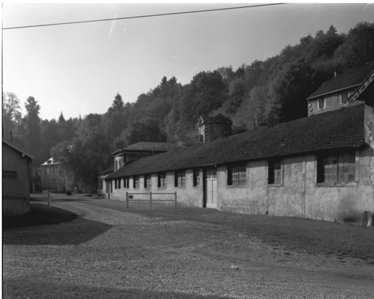
Façade est de l'atelier de fonderie en 1989.
