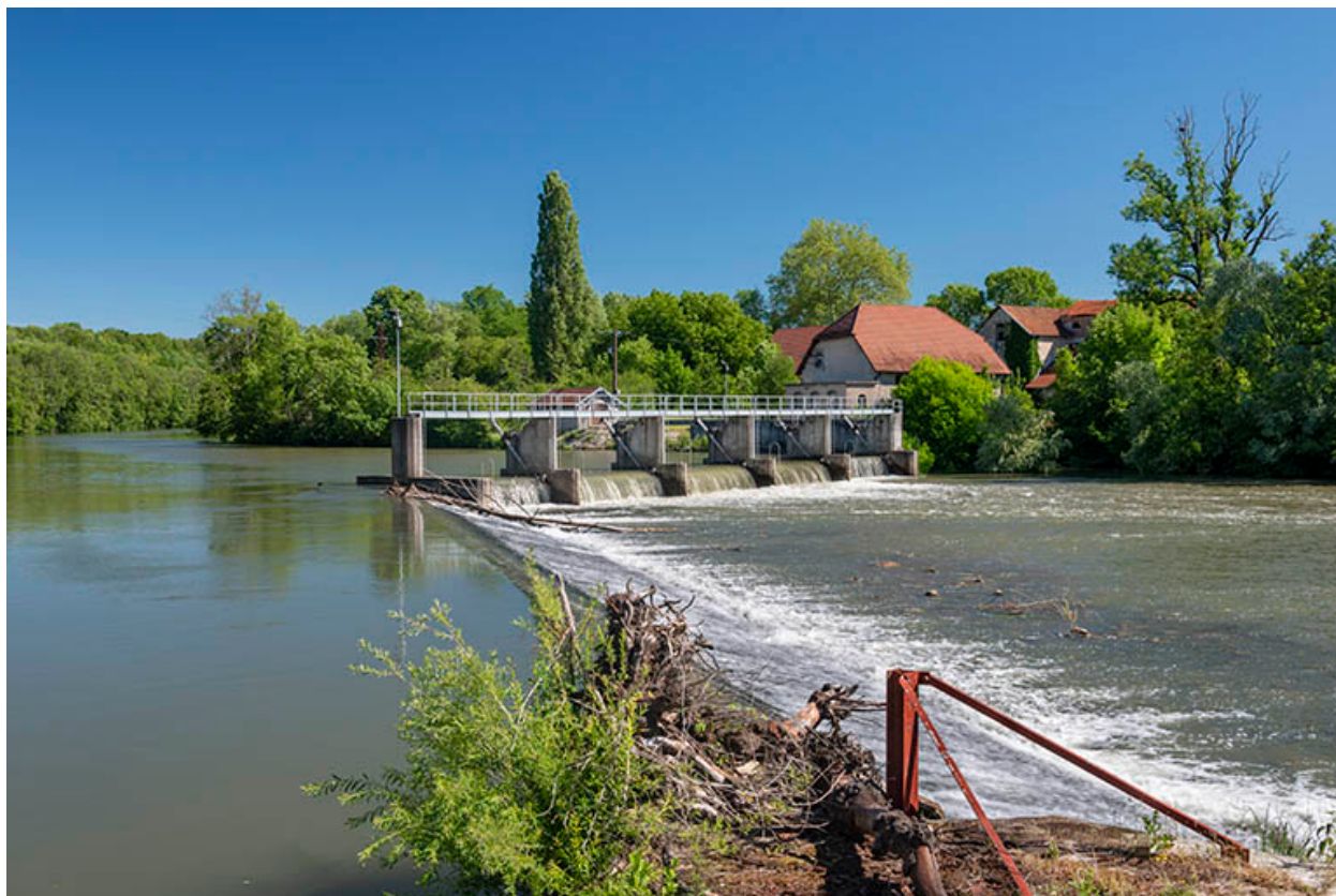
Site du barrage.
