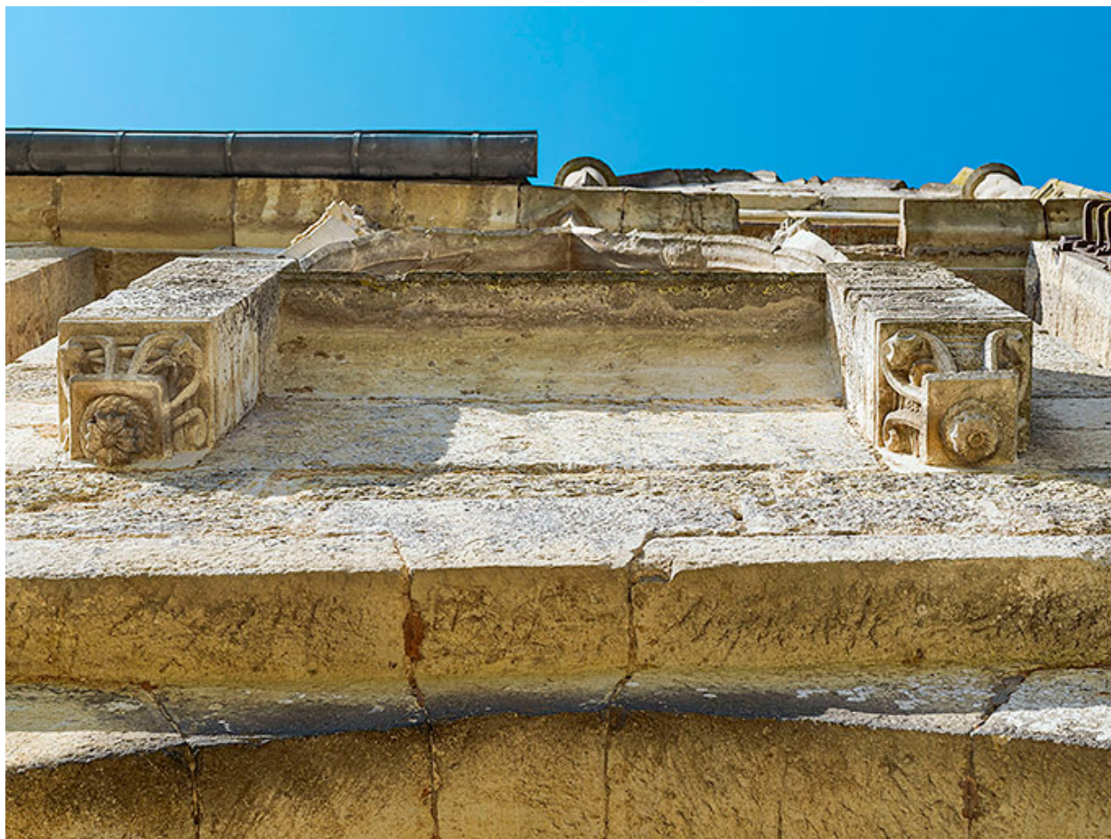
Base des piliers supportant les pinacles.
