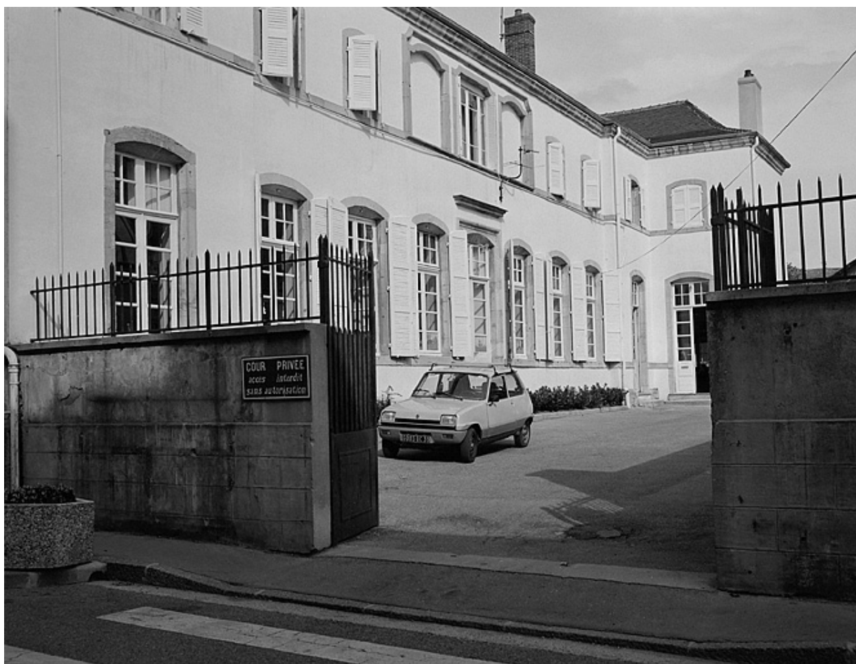
Façade postérieure, vue générale.
