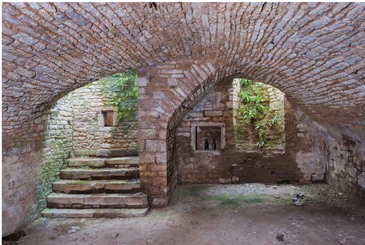
Vue générale de la cave
