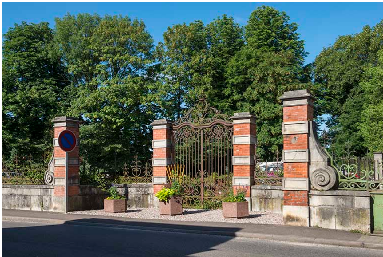
Clôture (grille) sur la rue Armand Paulmard.
