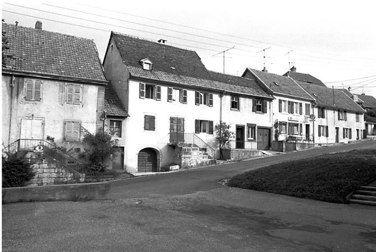
Alignement de maisons, rue de Montbouton
