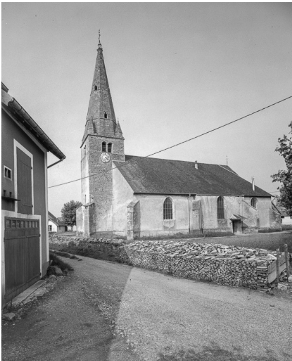
Façade latérale sud.
