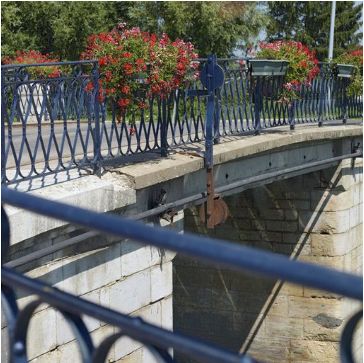
Détail de la poulie et du garde-corps.
