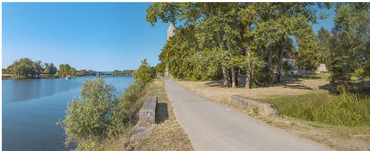
La digue de Chauvort, vue d'amont.
