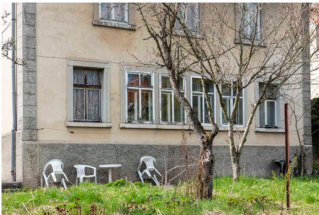
Façade postérieure : fenêtres multiples de l'atelier.
