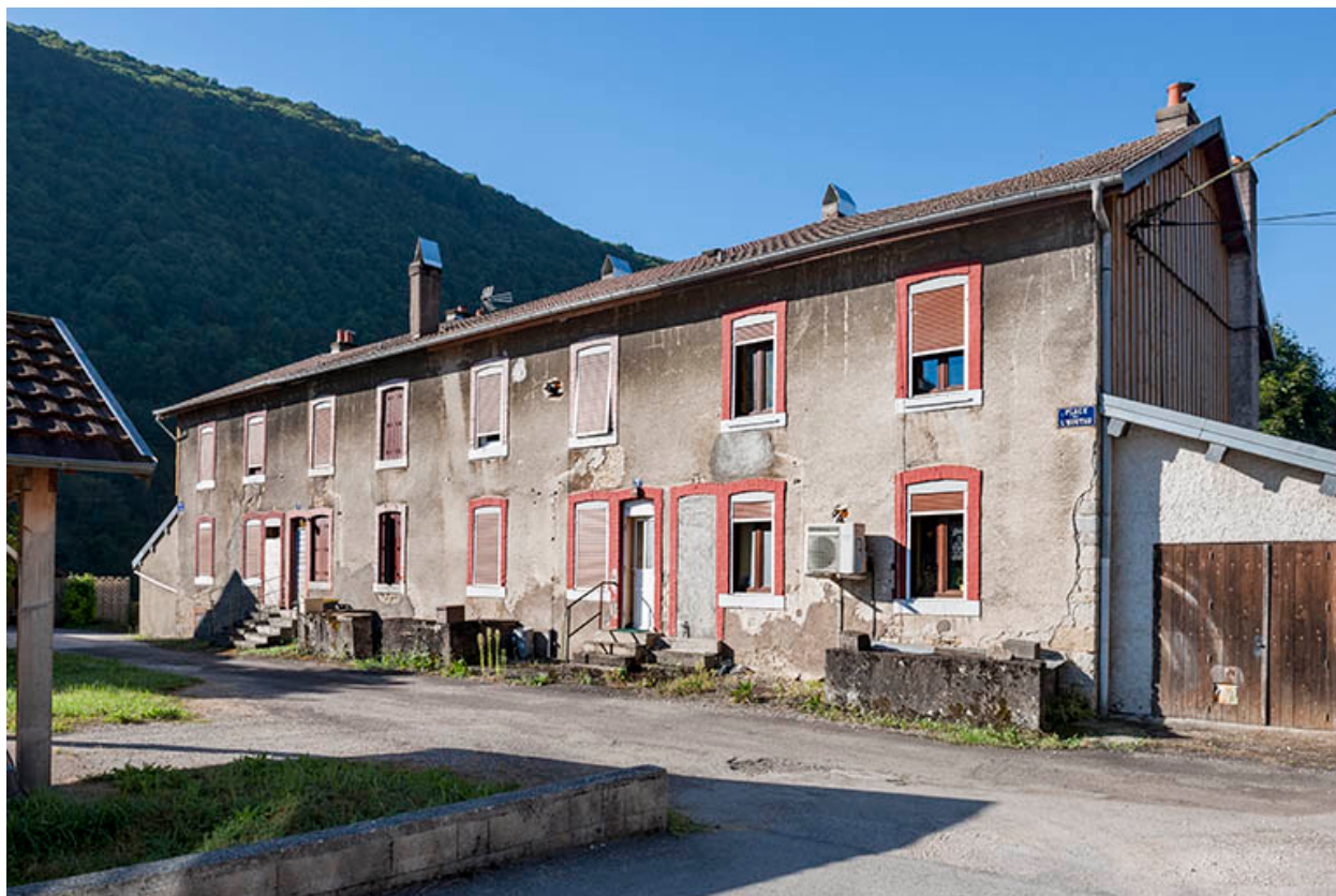
Logement ouvrier (8 appartements). Vue depuis le sud.
