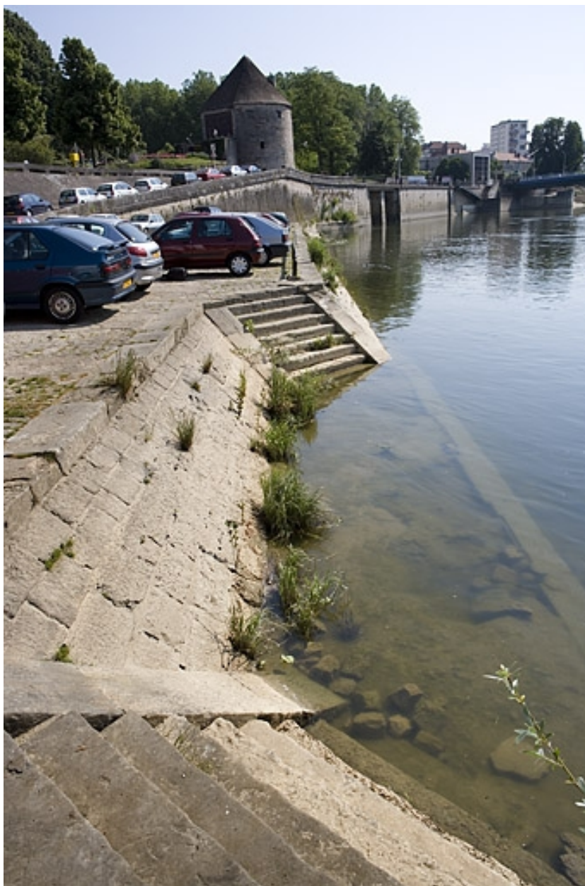
Escaliers d'accès au Doubs.
