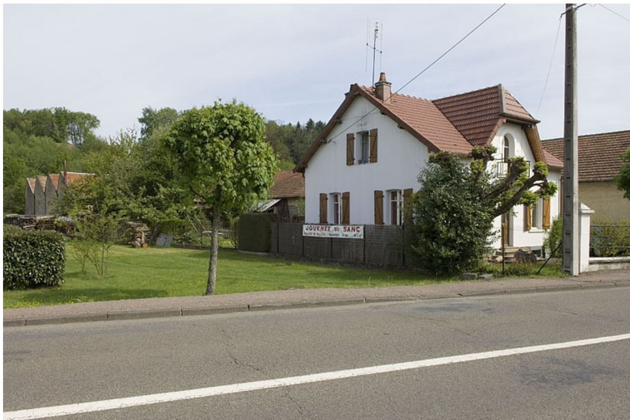
Vue d'ensemble depuis l'ouest.
