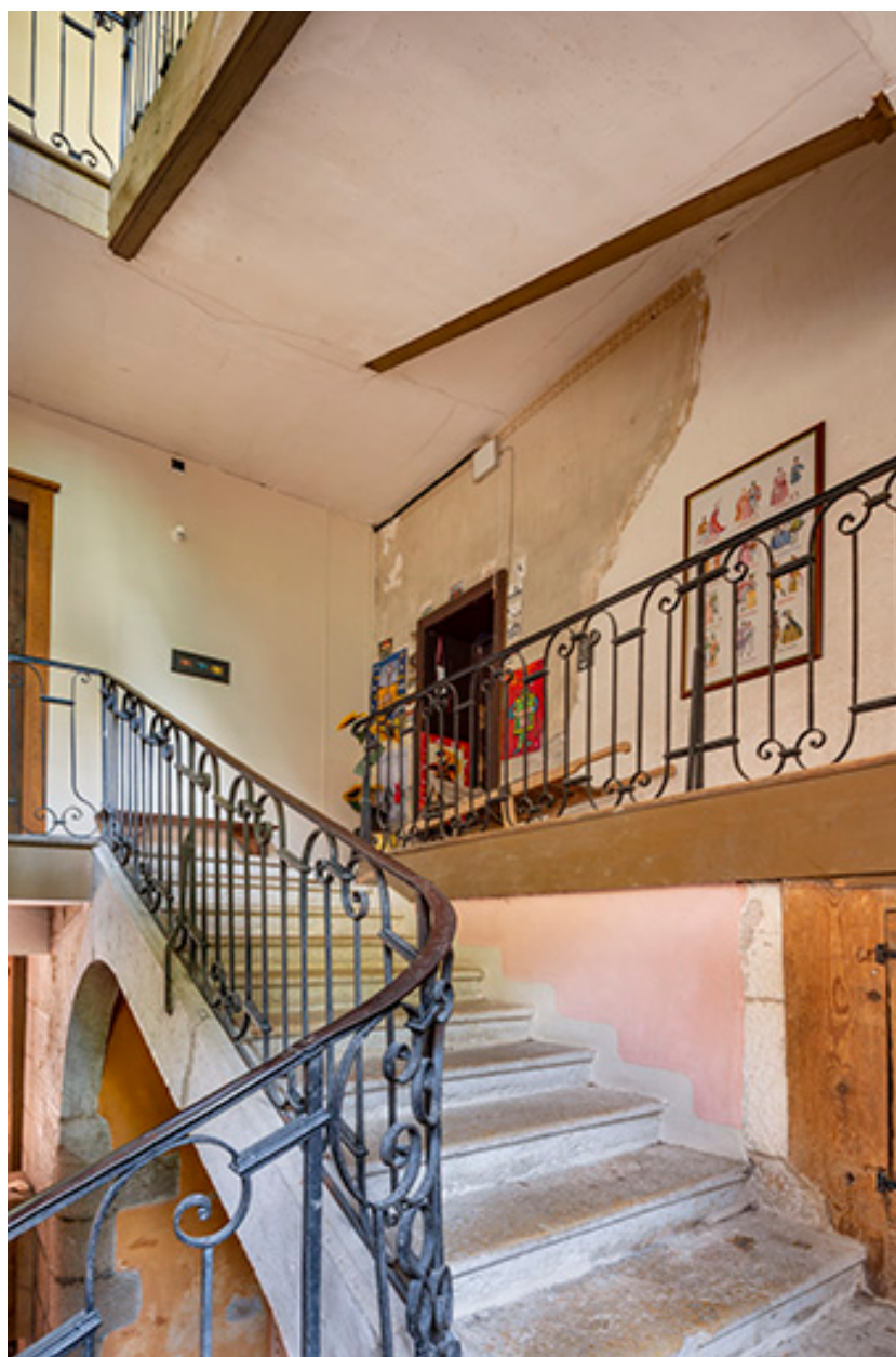
Cage d'escalier depuis la seconde volée.
