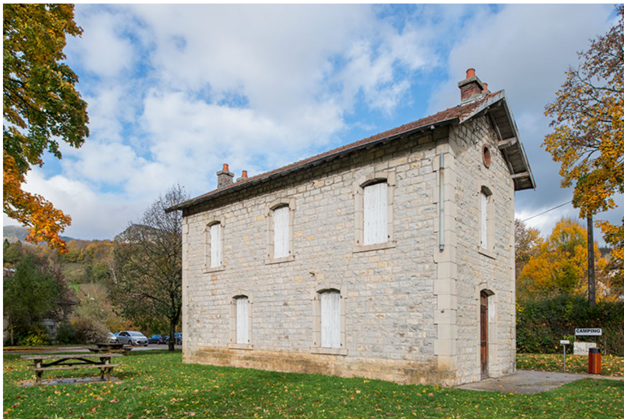
Vue de trois quarts depuis le sud-ouest.
