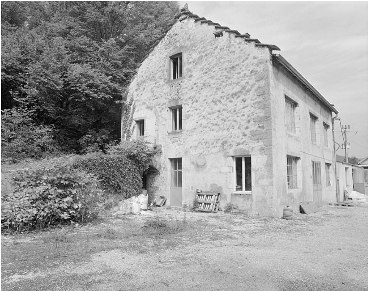
Façade antérieure et face gauche du moulin.
