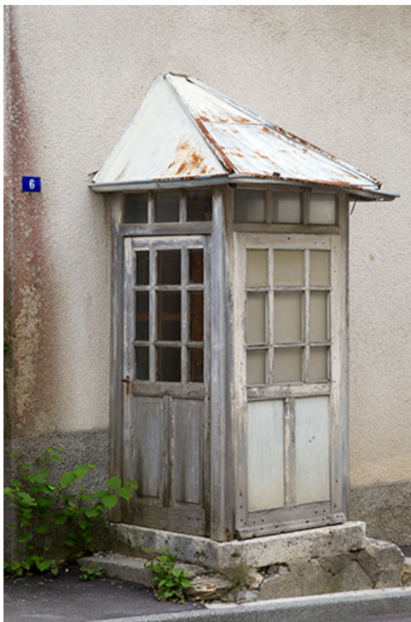
Façade antérieure : véranda.
