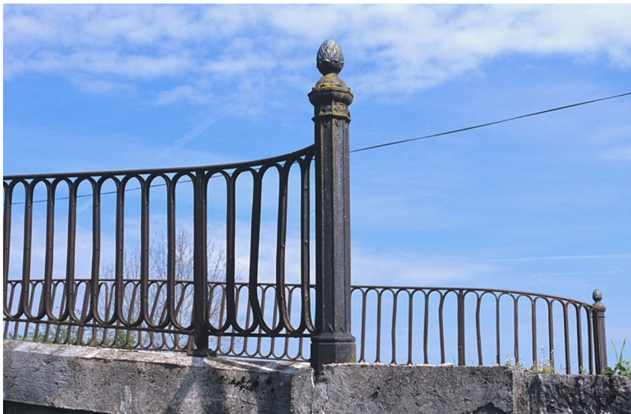
Potelet ouest du garde-corps nord.
