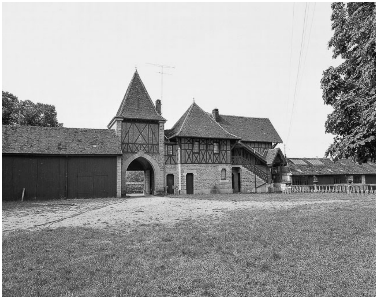
Bâtiment d'entrée : façade nord.
