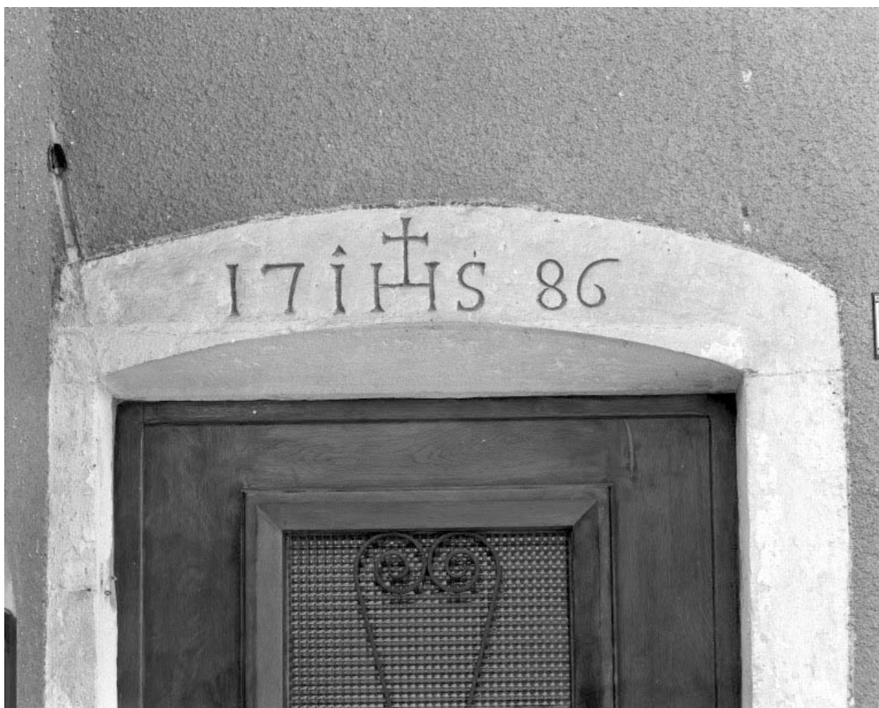
Linteau de la porte du rez-de-chaussée.
