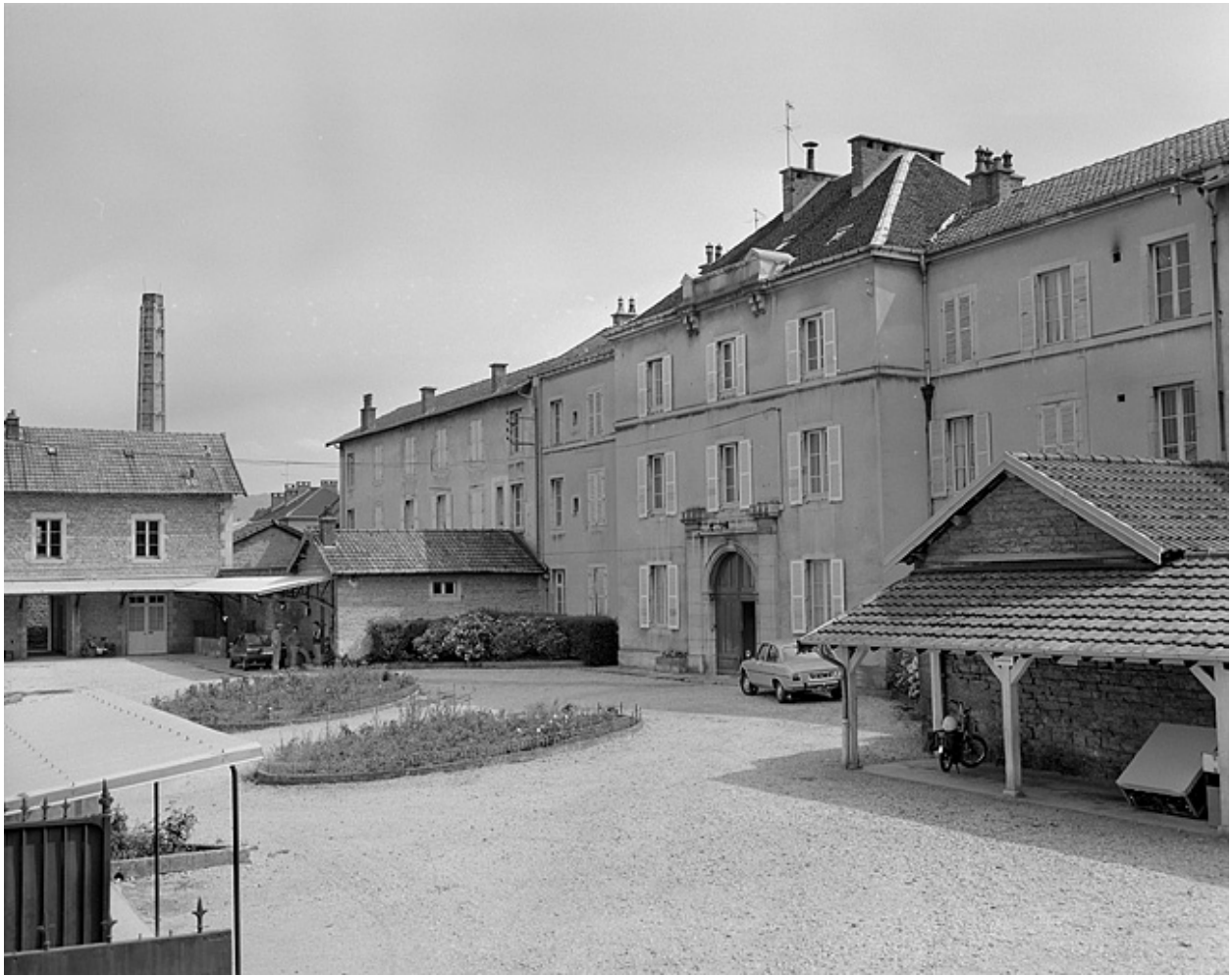
Façade principale sur l'avenue de Montciel en 1983.
