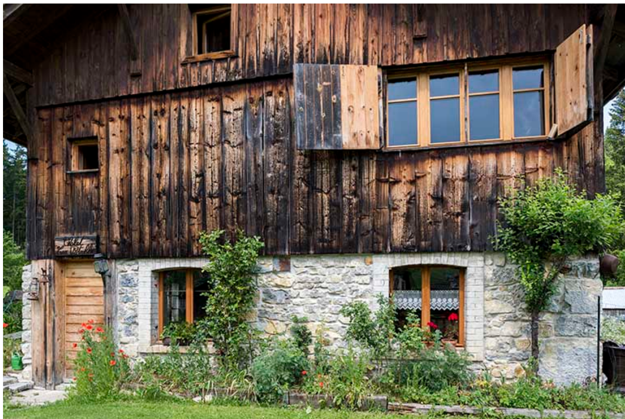
Façade antérieure : baies.
