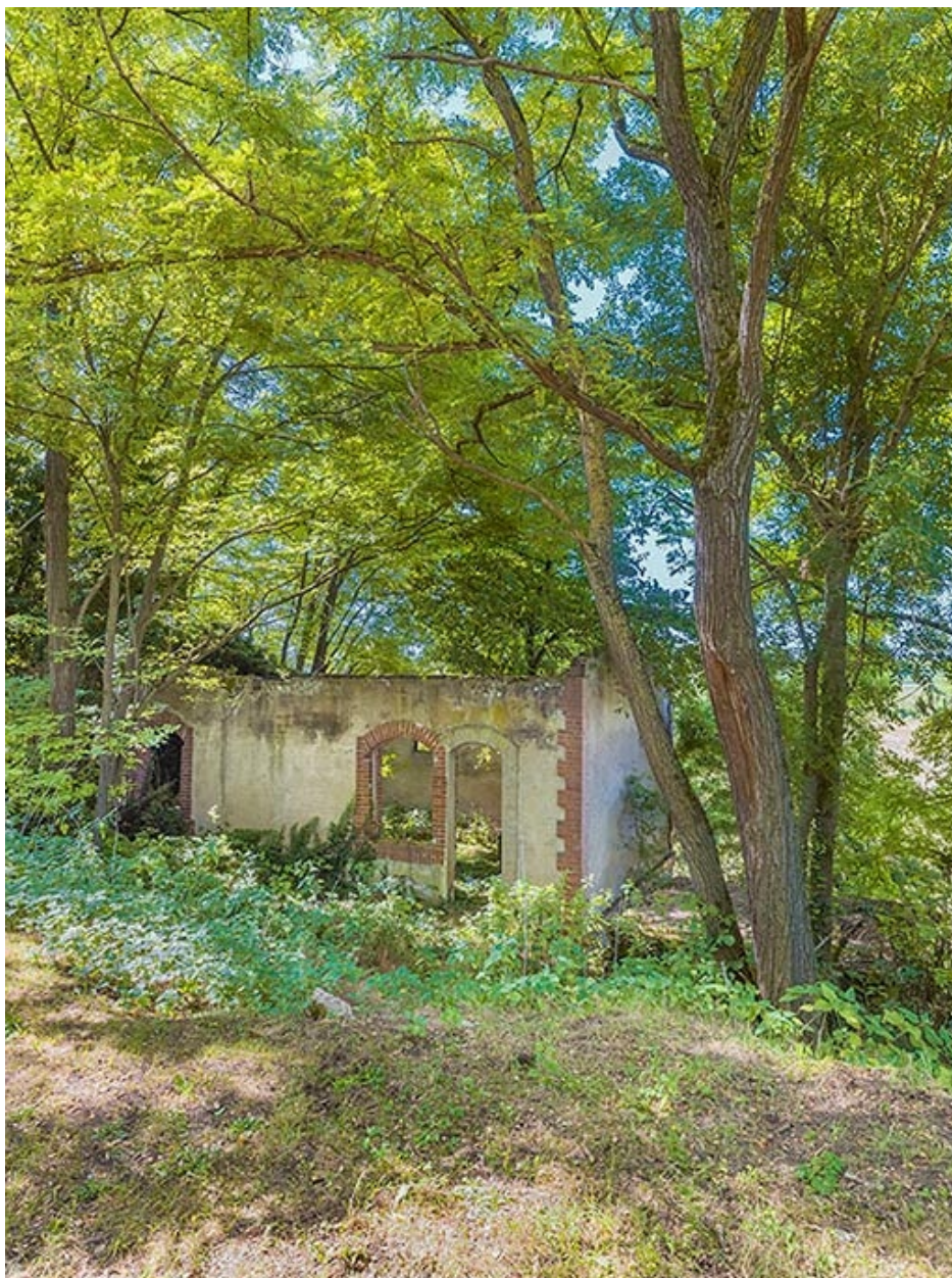
Vestiges d'un bâtiment (magasin ?), rive gauche.
