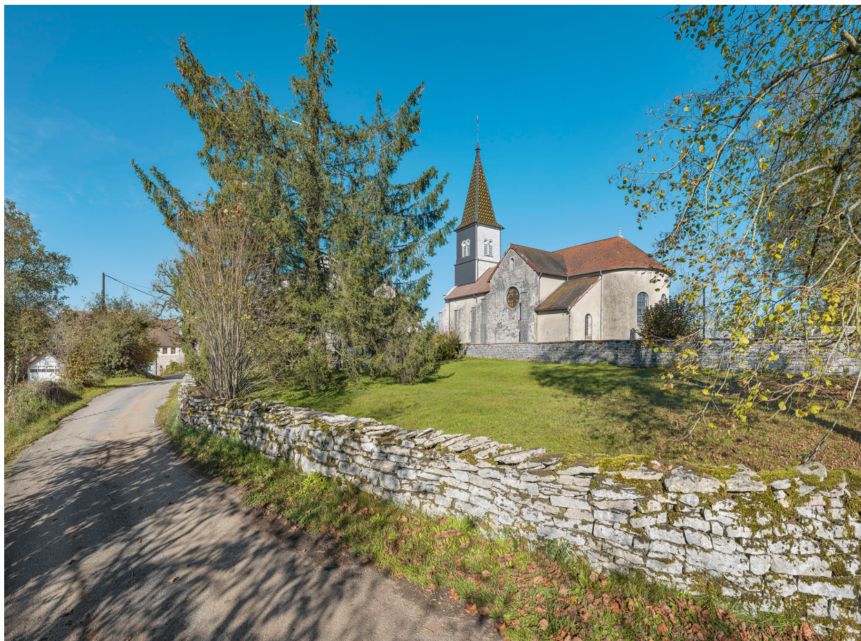
Vue d'ensemble : élévation sud et chevet.
