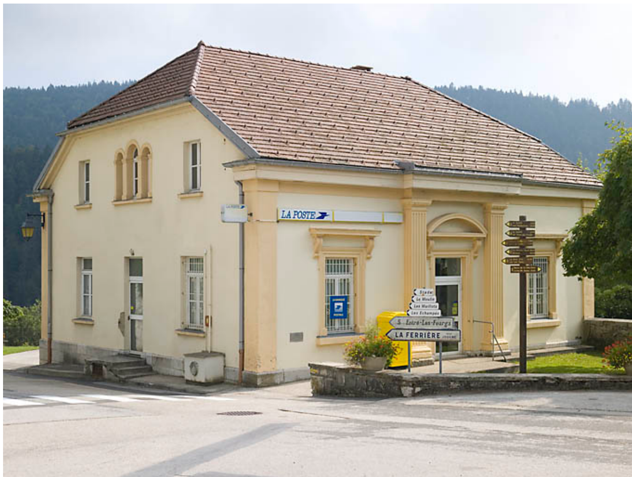
Façade antérieure et façade latérale gauche.
