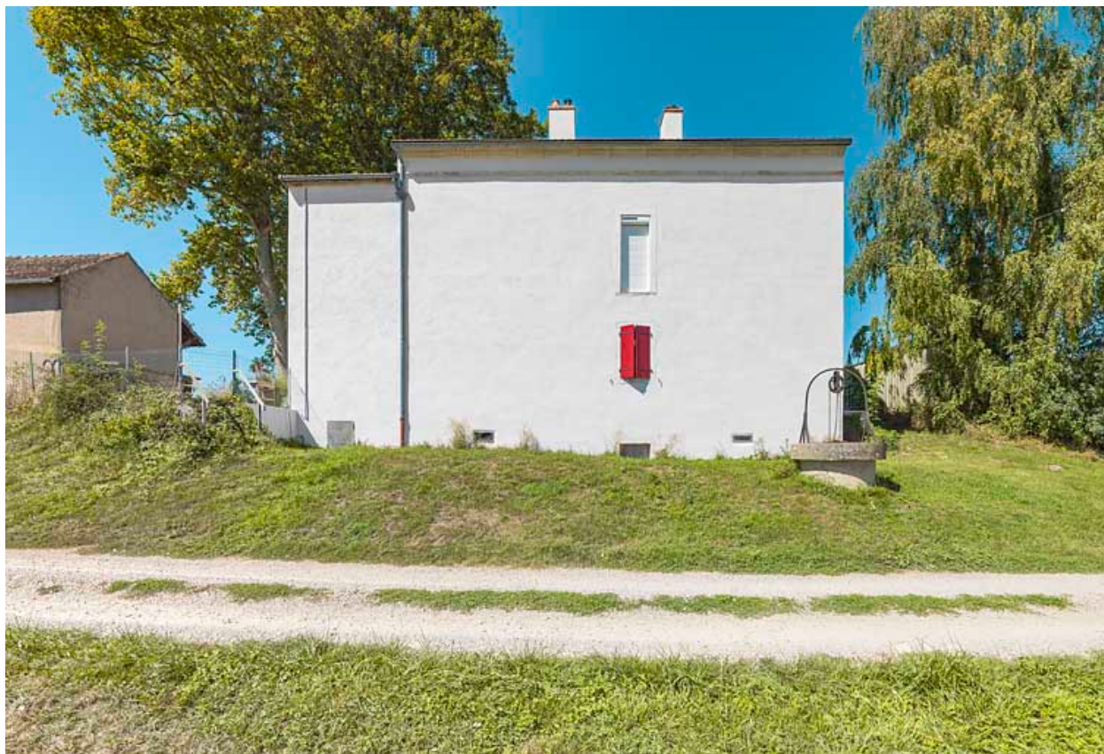
La maison éclusière : face arrière.
