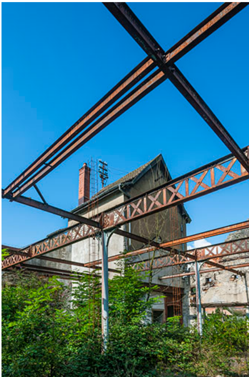
Charpente métallique de l'atelier de fabrication.
