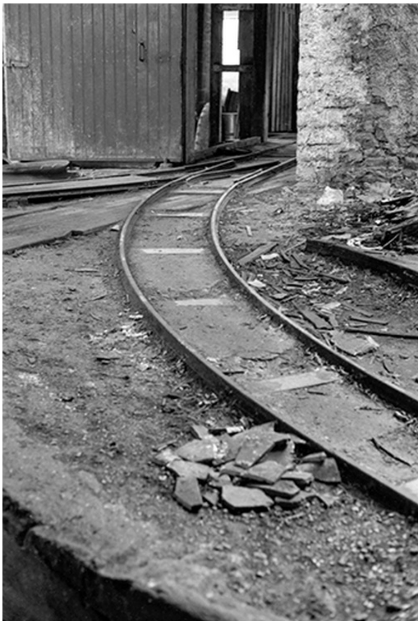
Voie Decauville à l'entrée d'un atelier en 1979.
