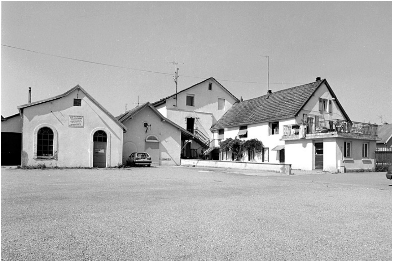
Pignons des ateliers depuis la cour.
