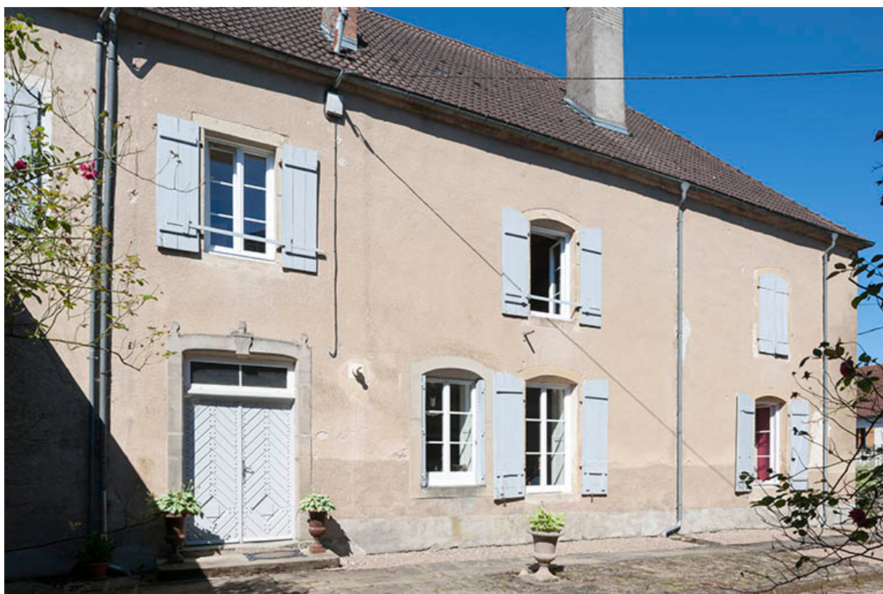
Vue générale, façade est.
