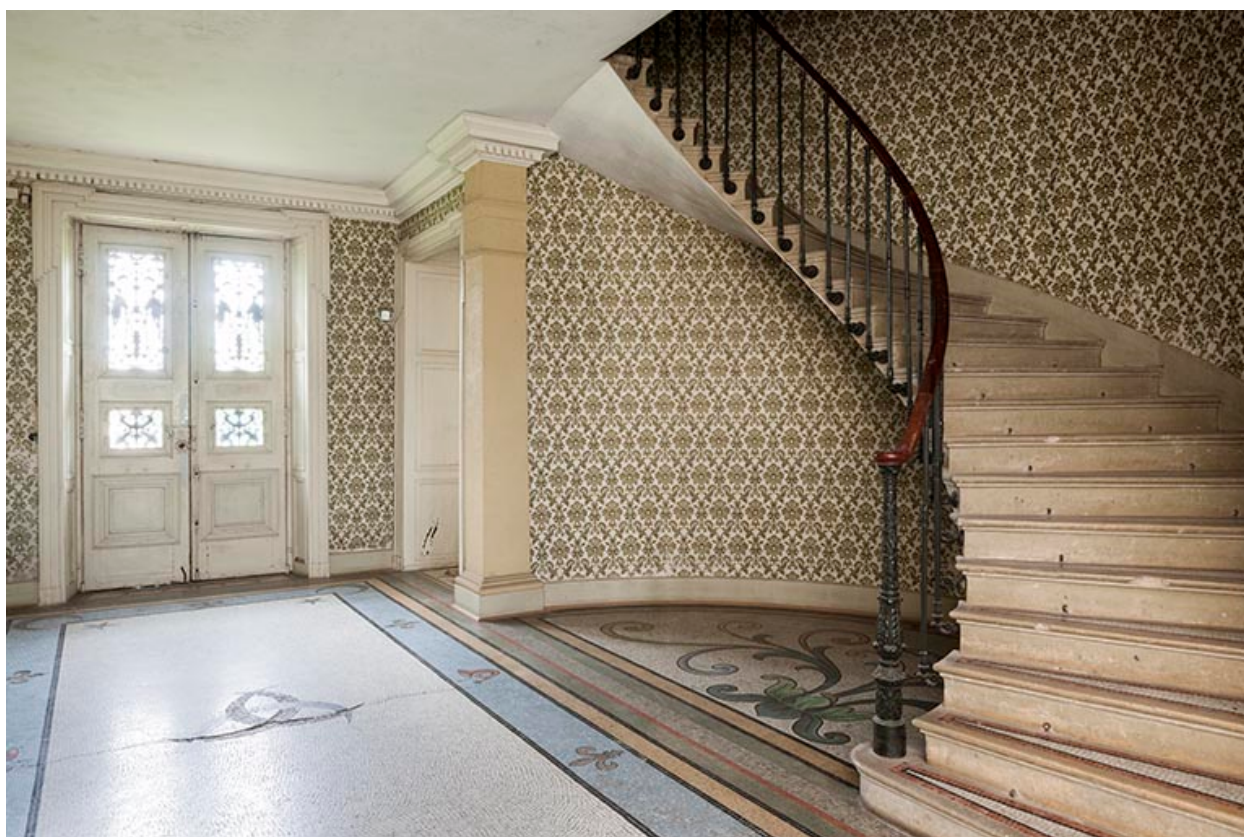
L'escalier en vis suspendu.
