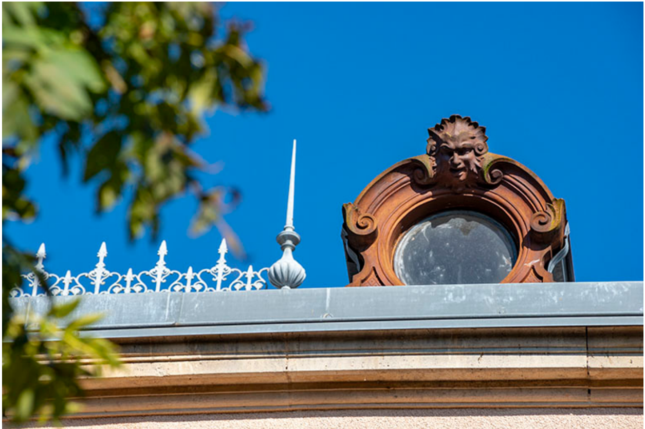
Lucarne, façade postérieure.
