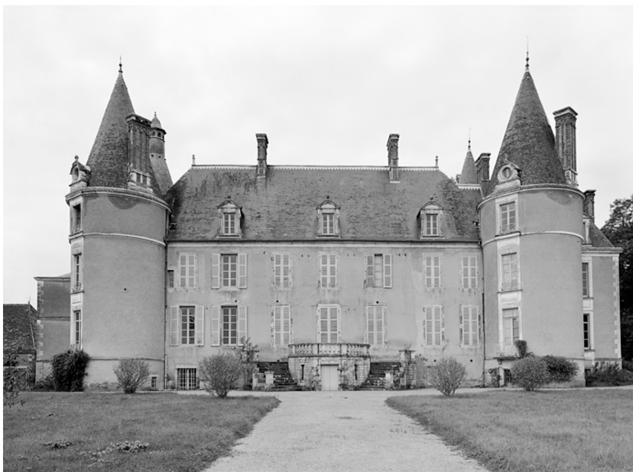
Façade postérieure du logis.
