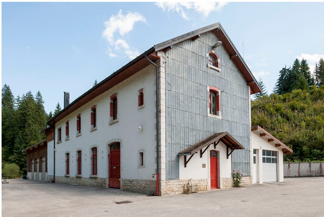
Centrale vue de trois quarts droite.
