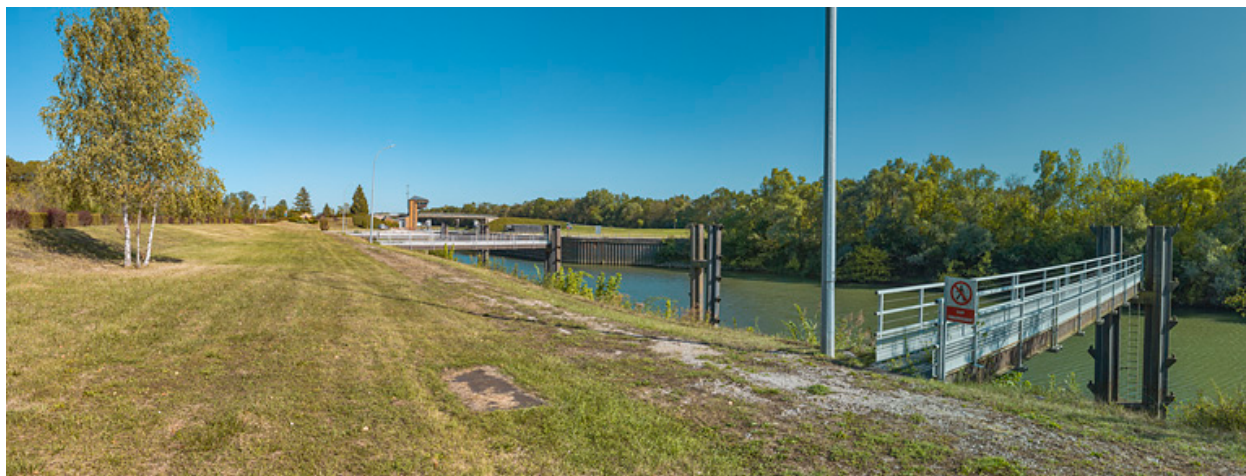
Le site d'écluse vu d'aval.
