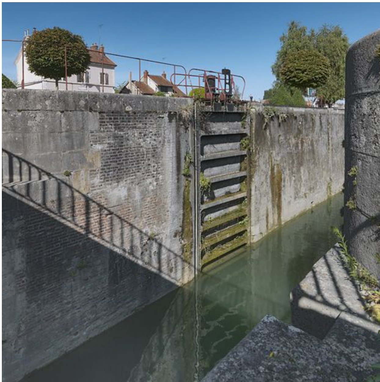
Site d'écluse vu d'amont : bajoyer en brique.
