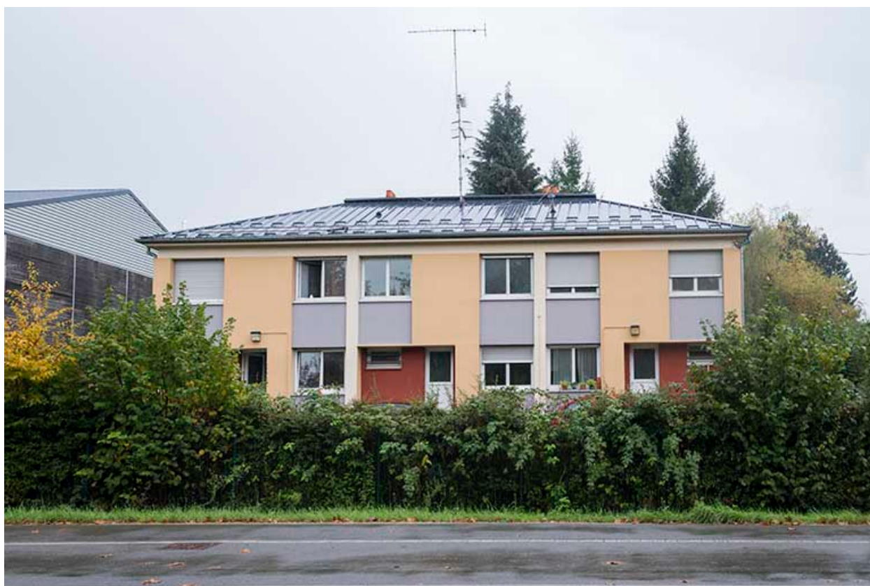
Façade nord du bloc des logements nord.
