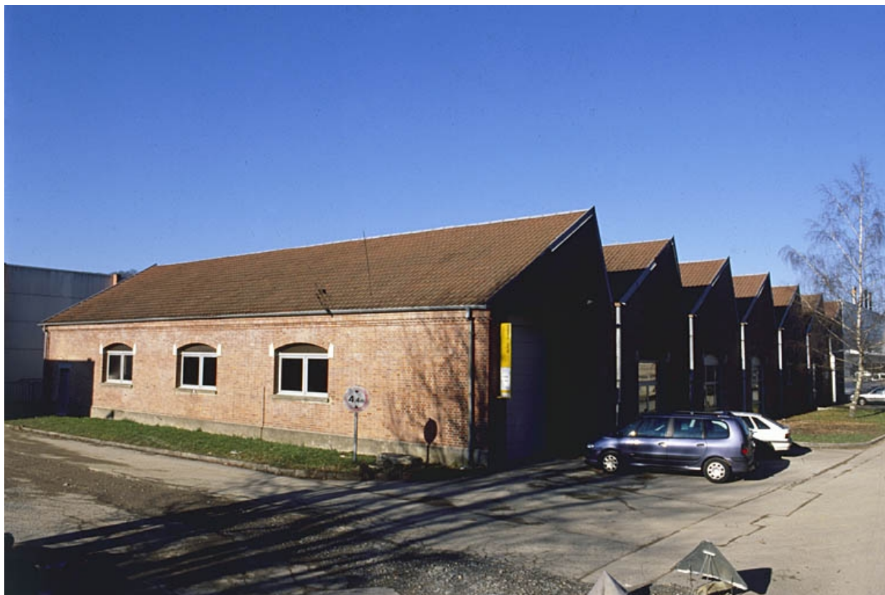
Atelier de teinturerie : vue depuis le sud-est.
