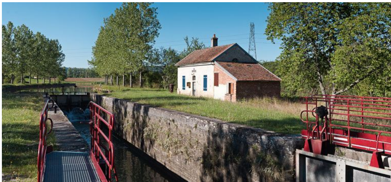
Vue d'ensemble du site d'écluse.
