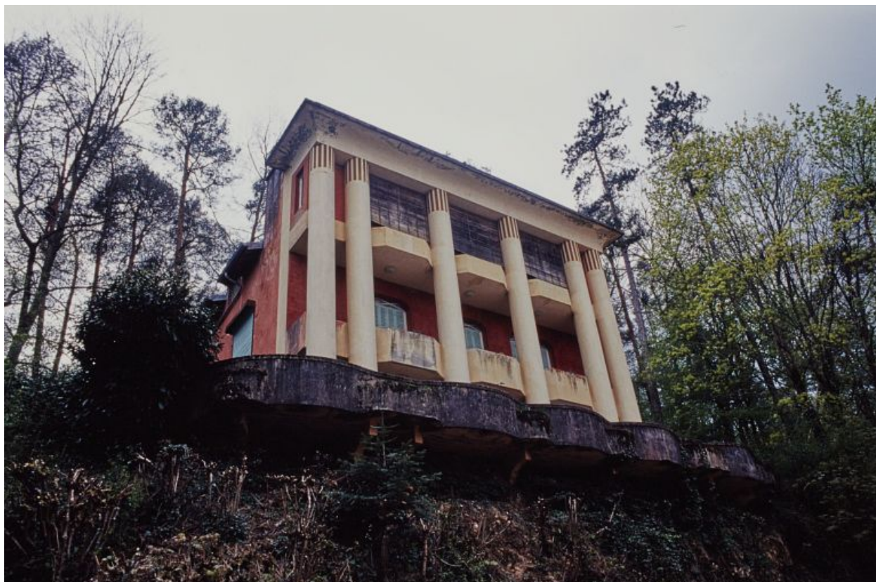
Façade nord, vue en contre-plongée.
