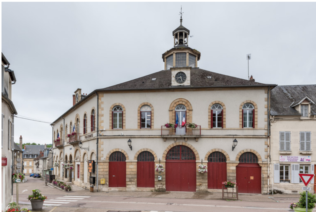
Façade latérale droite.
