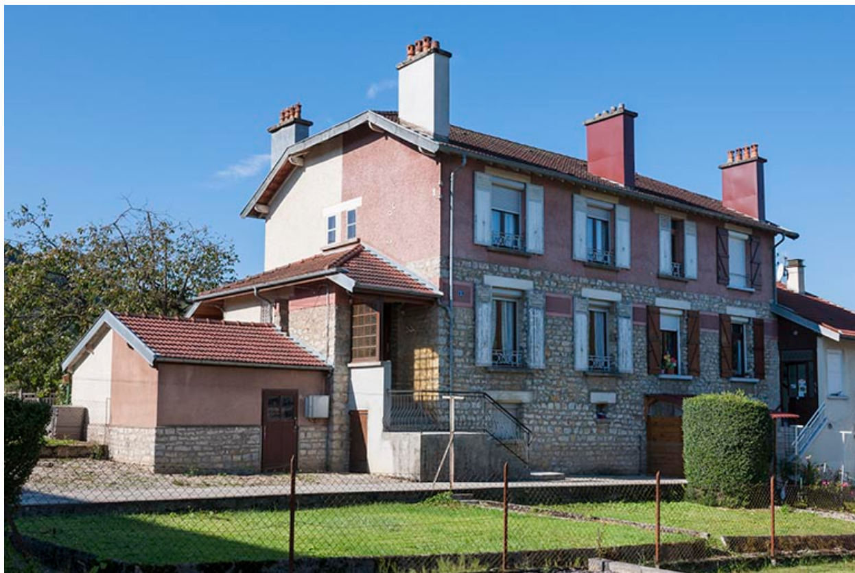
Maison à quatre logements. Vue trois quarts.
