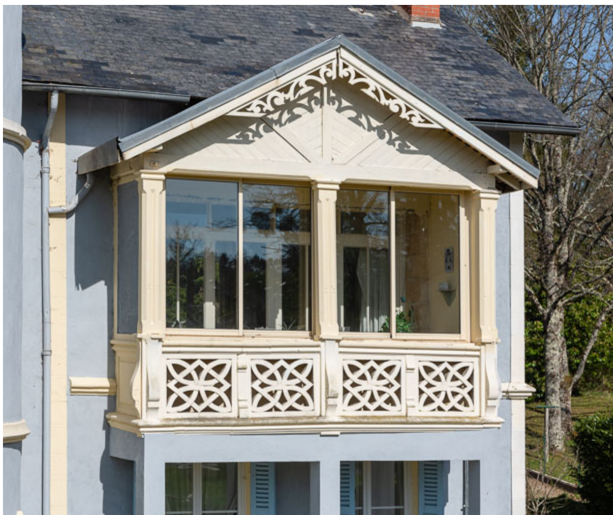
Façade sud-est, oriel.
