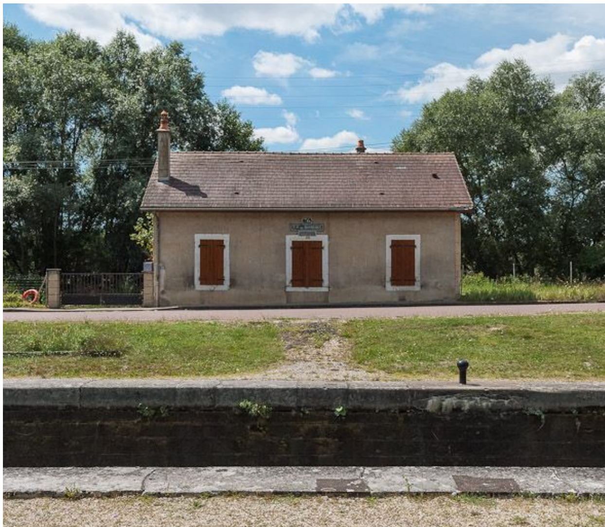
La maison éclusière de face.
