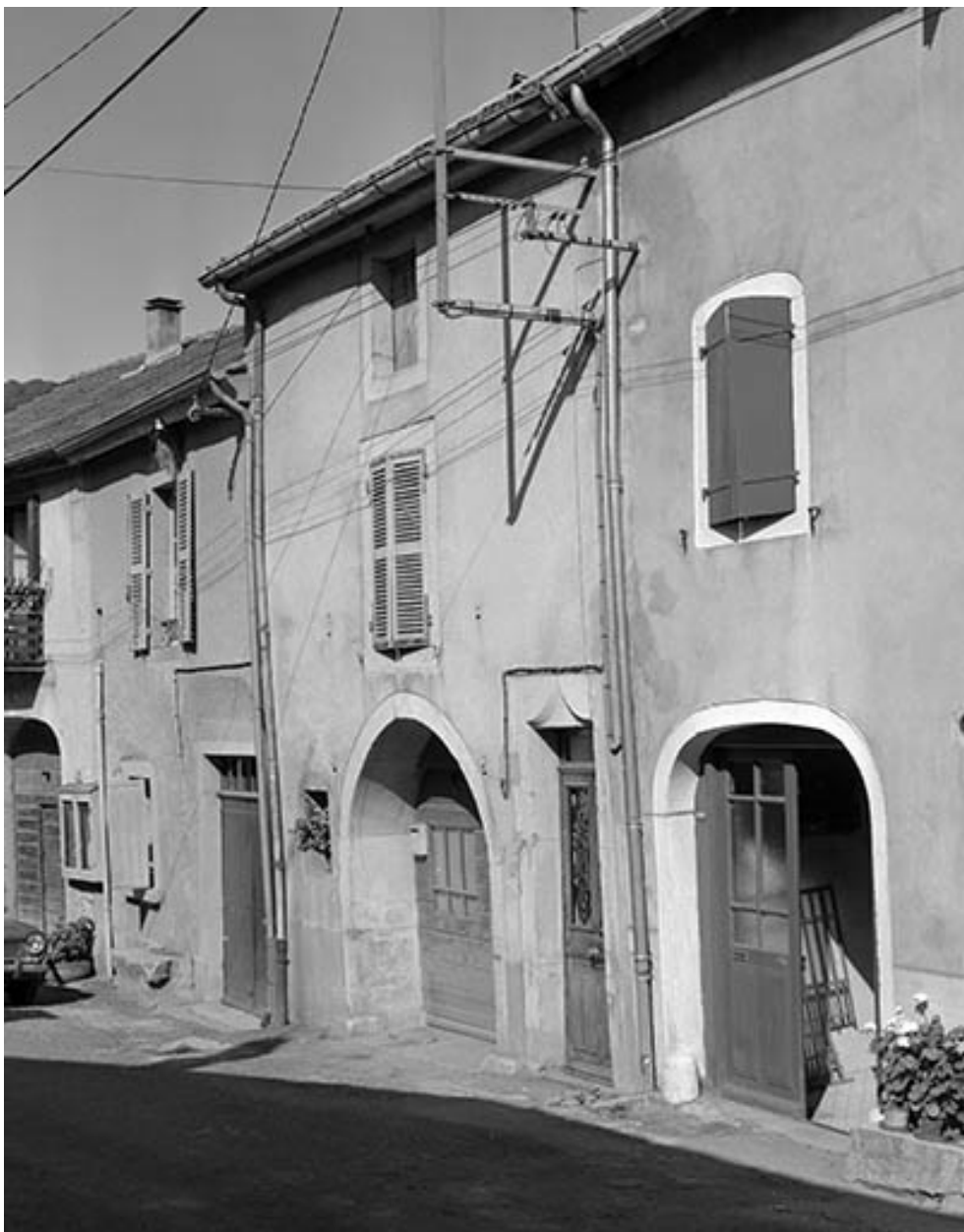
Façade antérieure, trois quarts droit.
