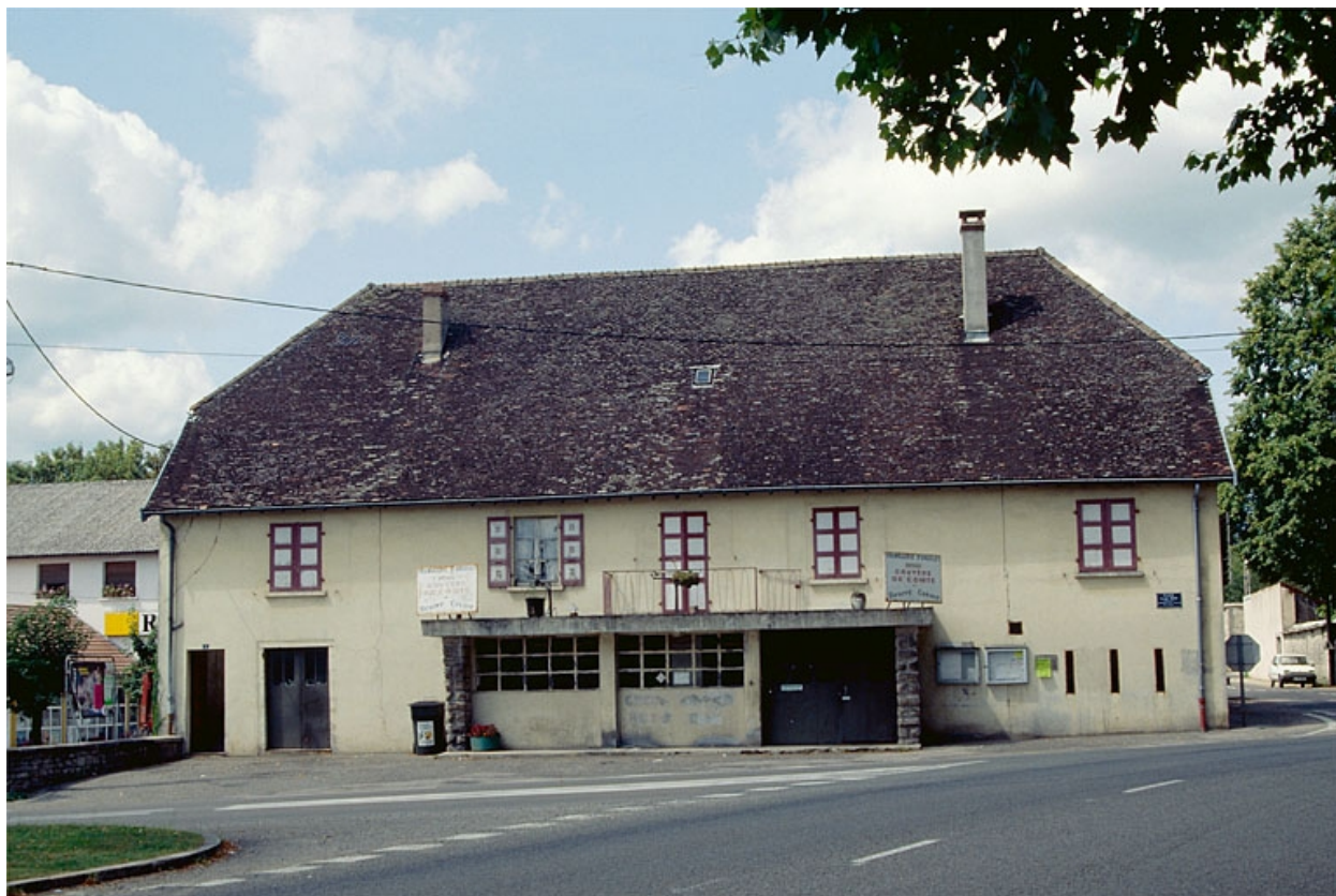
Fromagerie vue de face.
