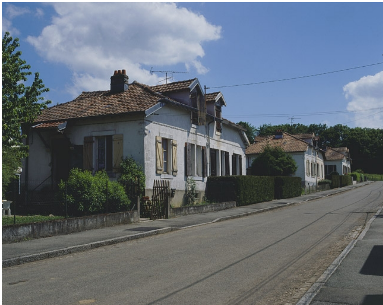
Maisons jumelées à 4 travées rue de Normandie.
