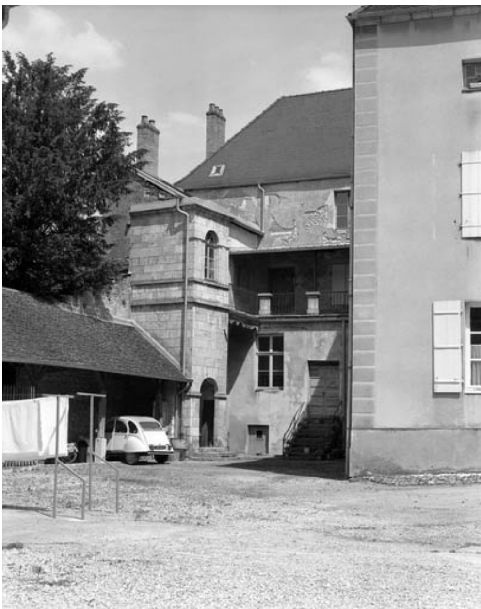
Façade antérieure : détail.
