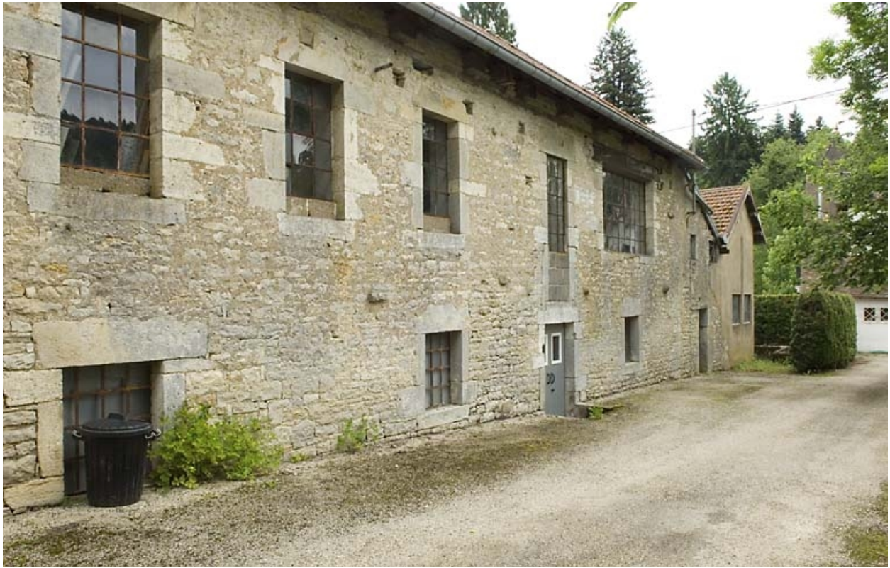
Façade ouest de l'atelier de fabrication.
